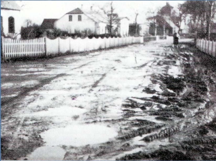
Schlechte Wegstrecke von Hattlundmoor
